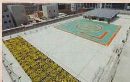
(屋上緑化・太陽光発電)
