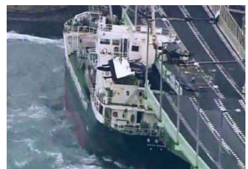
台風21号の強風で関空連絡橋に衝突したタンカー(4日午後)＝近畿地方整備局提供
