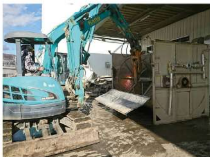
壊れた機械設備の運び出し
