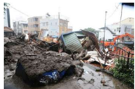
大規模な土石流が発生した伊豆山地区＝4日午前、静岡県熱海市
