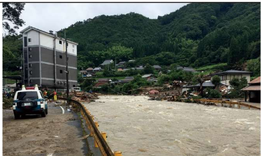
西日本豪雨で被災した旭酒造本社
