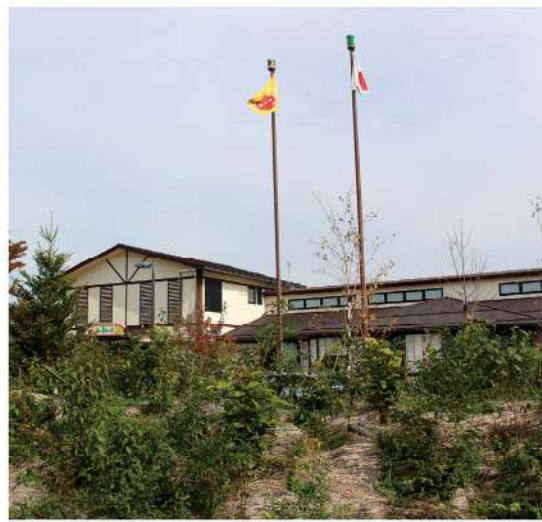
敷地を囲うように土を盛り、木を植えて防災林兼憩いの場にする。パン工場や管理棟は現在工事中。復興のシンボルとして掲げた社旗と国旗は、被災後、一度も降ろしていない
